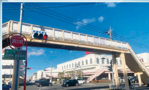
東大淀歩道橋（宮崎土木）
