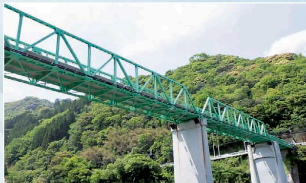
早日渡橋（延岡土木）
