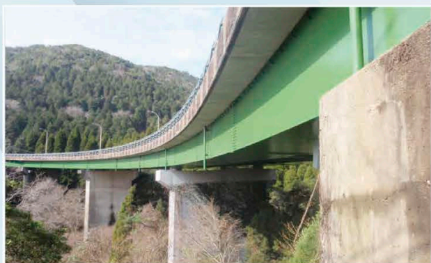
北野大橋（小林土木）
